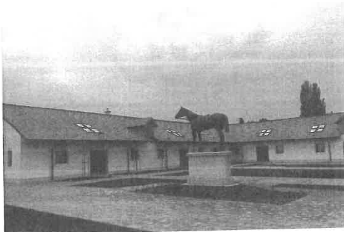
Felújított Kincsem istálló (fotó: Bea István)
