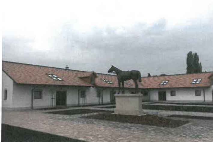
Felújított Kincsem istálló (fotó: Bea István)
