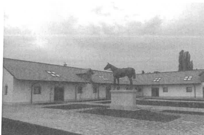
Felújított Kincsem istálló (fotó: Bea István)
