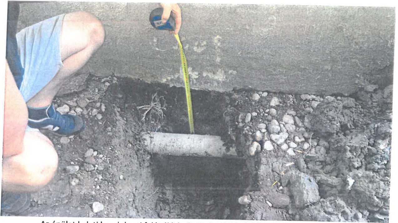
Az épület keleti homlokzati falánál készített alapfeltárás képe (alapozási sík: 40cm)
