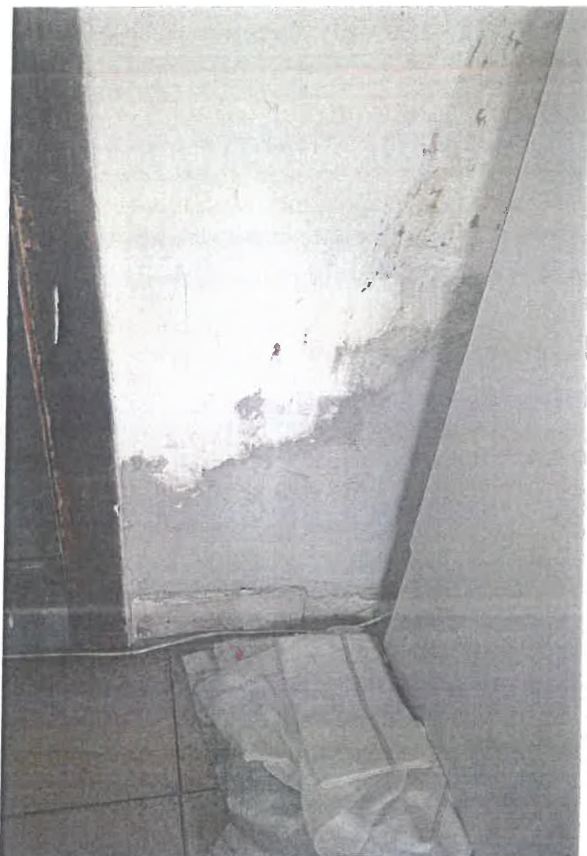
Vakolatleválásos meghibásodások javítása
