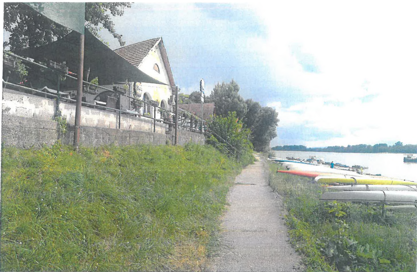
Az épület látképe Északnyugat felől, háttérben a sportlétesítmény épületével.
