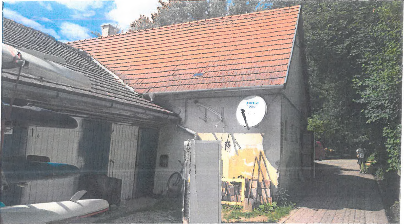
Az épület homlokzata délkeleti irányból
