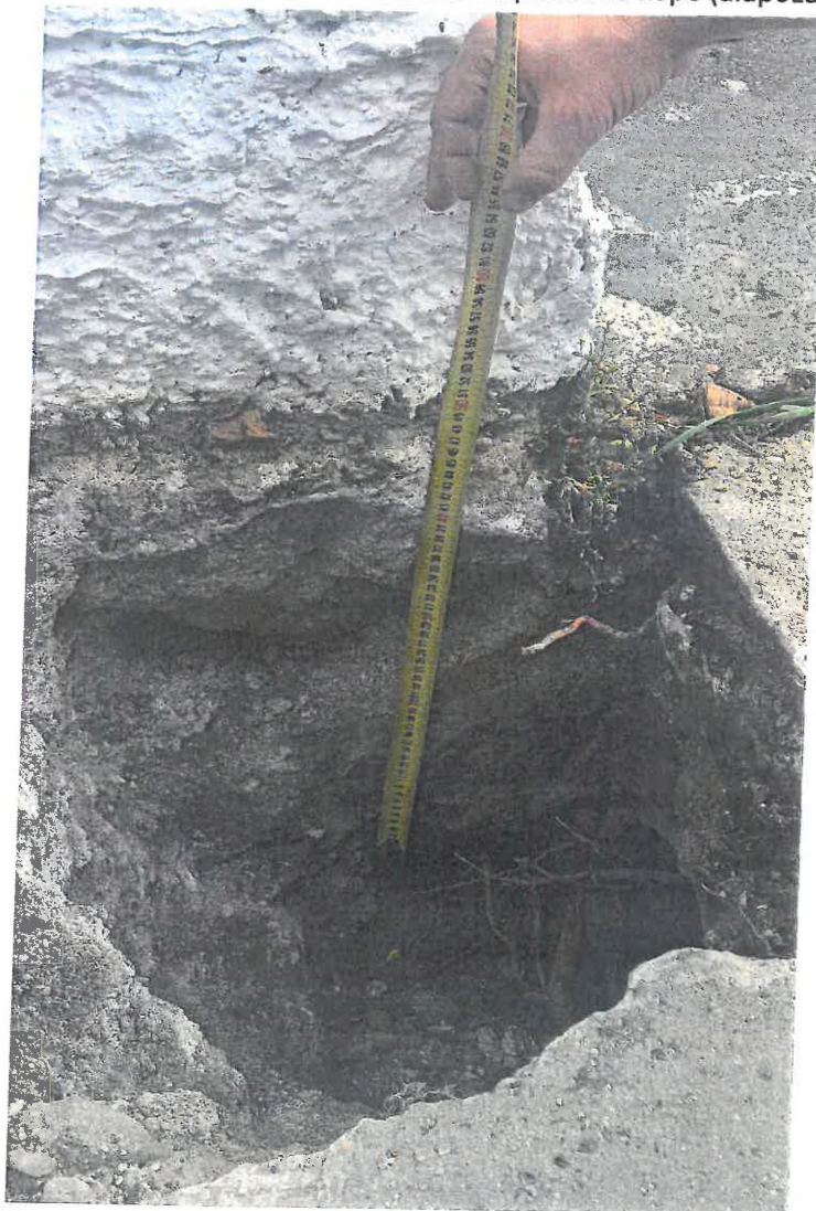
Az épület északnyugati sarkának alapfeltárása (alapozási sík -0,40m)
