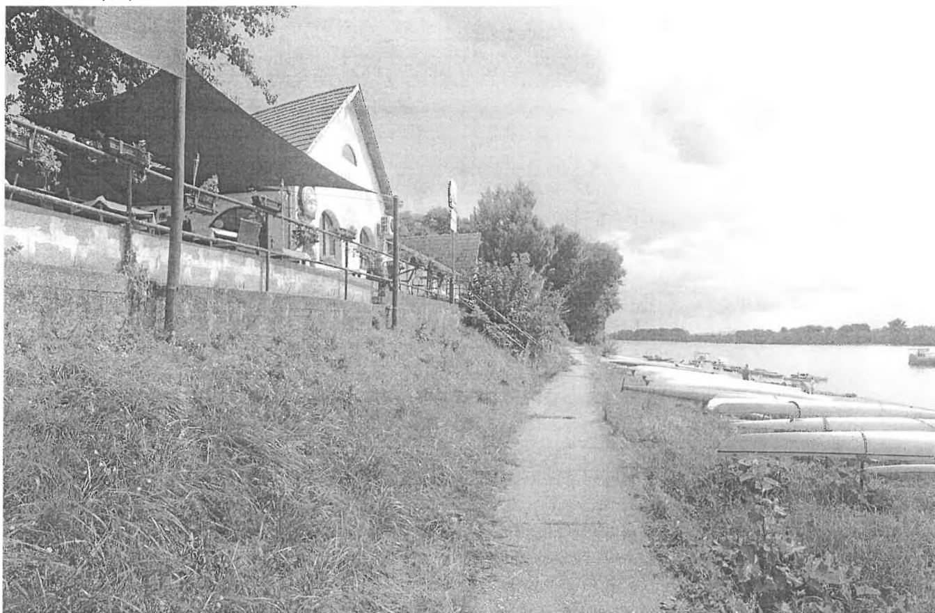
Az épület látképe Északnyugat felől, háttérben a sportlétesítmény épületével.
