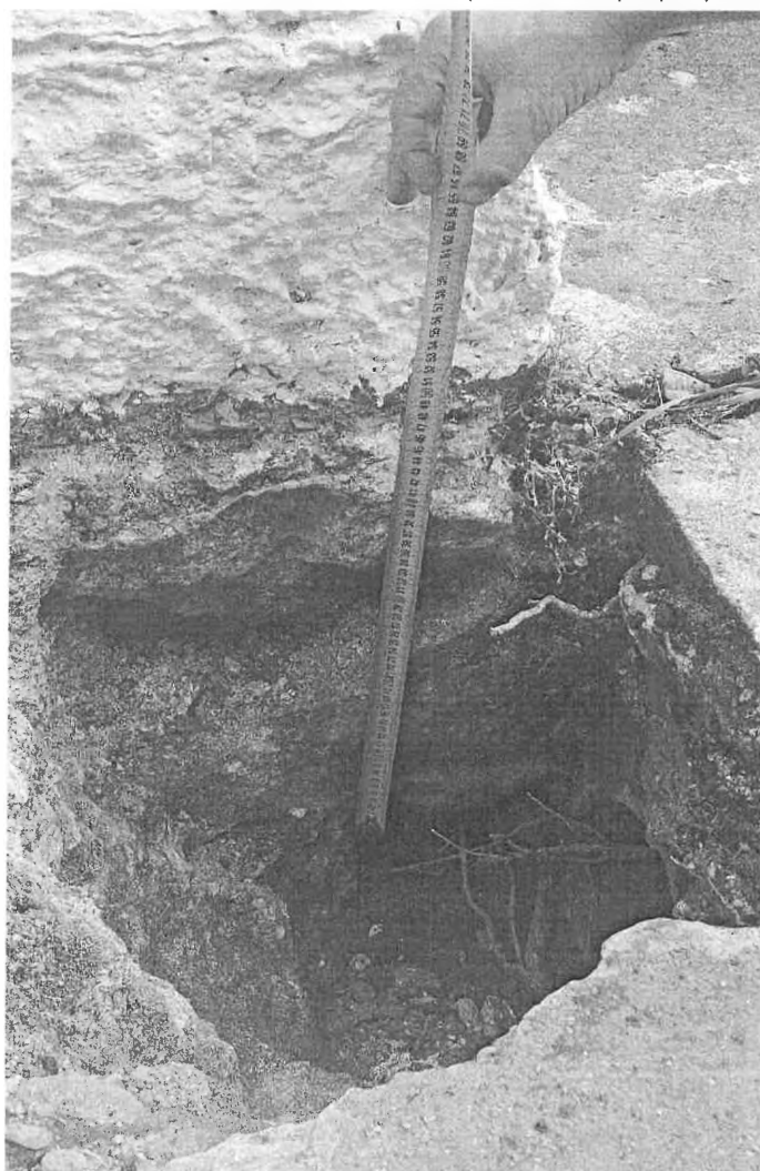
Az épület északnyugati sarkának alapfeltárása (alapozási sík -0,40m)
