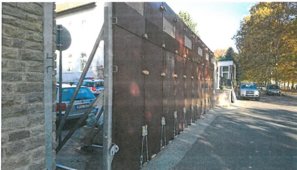
2. ábra mobil gát utca felőli szakasza
