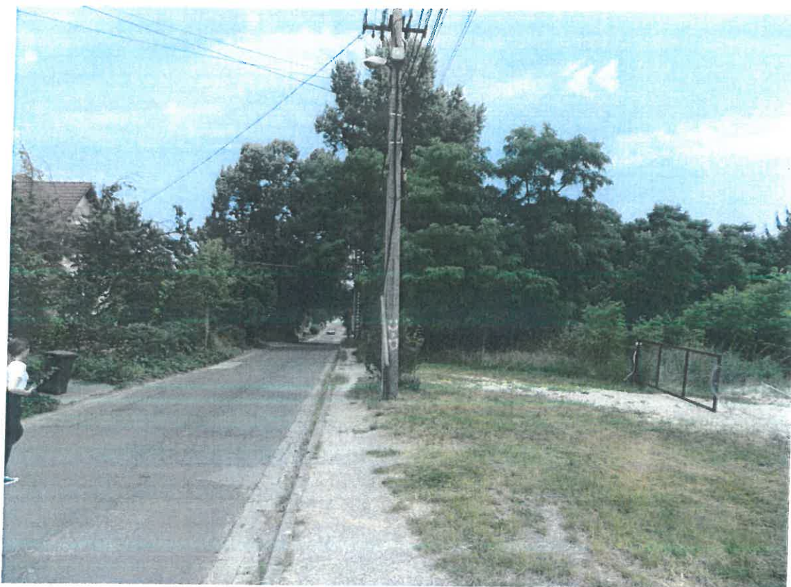
63. SPORTLÉTESÍTMÉNYEK FEJLESZTÉSE, KÖZINTÉZMÉNYEK ENERGETIKAI FEJLESZTÉSE
