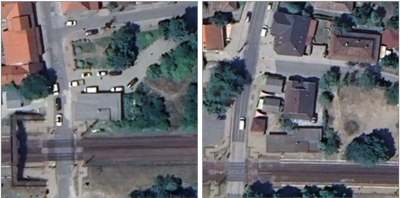
Meglévő épületállomány Alsógöd és Felsőgöd vasúti megállóhelyek környékén (Forrás: Google Earth)
