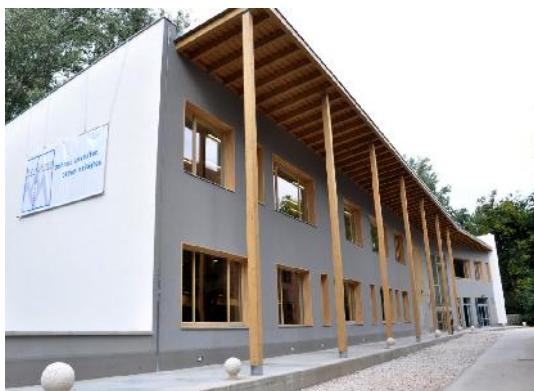
A Piarista iskola műhelyépülete. Visszafogott stílusával szépen hangsúlyozza a villaépületet. (tervező Golda János Ybl díjas építész)
